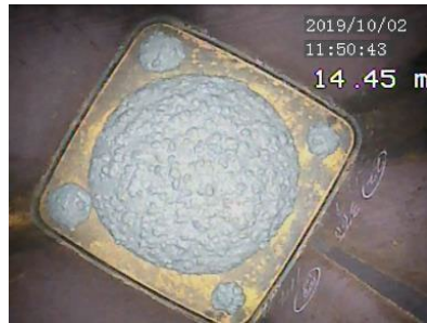
CFT柱の充填コンクリート 高強度・高流動な低炭素コンクリート
