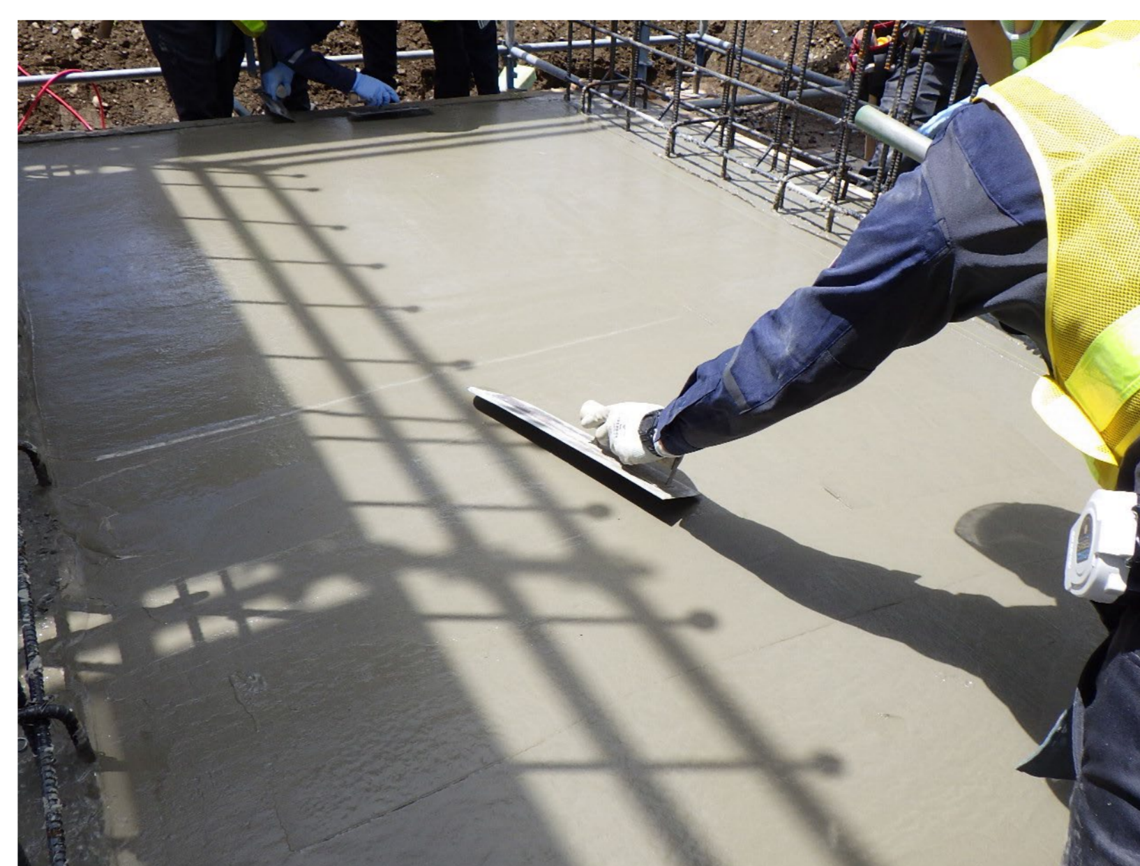
[仕上げの状況]
