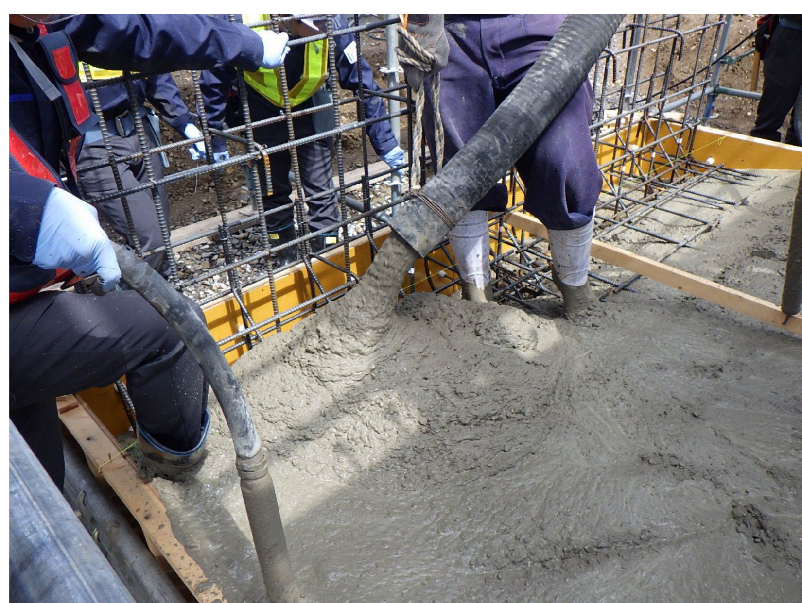
[打込みの状況]
