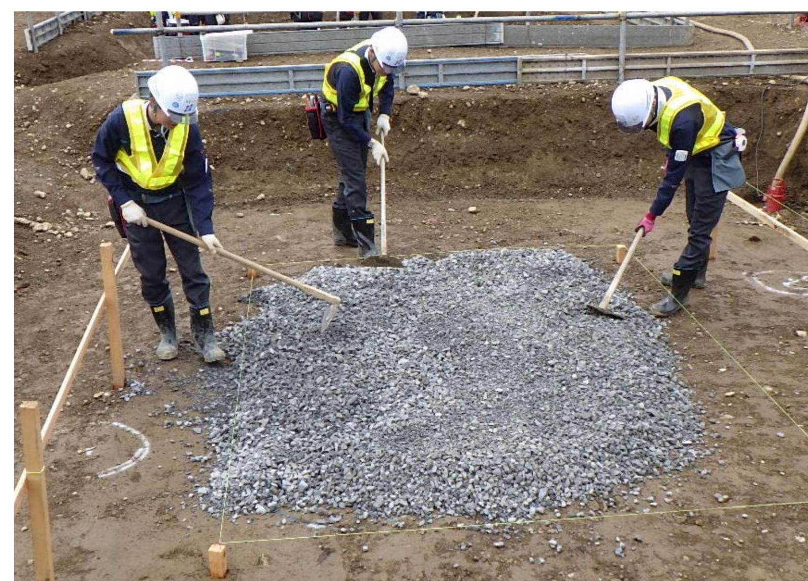
[基礎砕石としての施工状況]
