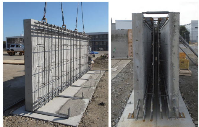
写真1 PCa板設置状況（施工実験）
