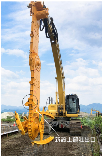
WILL-m工法施工機械全景
