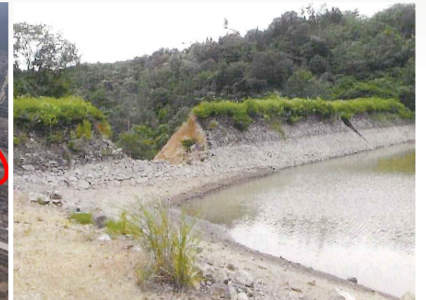
ため池豪雨被害（大田池、岡山県） 出典：西村ら、2018年7月豪雨における岡山・広島のため池災害、基礎工2020.6
