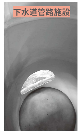
スラスラ工法で修繕した1号マンホール試験体
