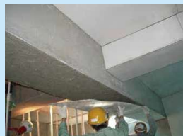
シート差込み状況
