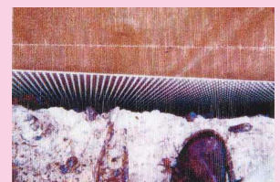
高架道路のエキスパンション
