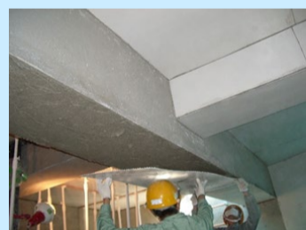
シート差込み状況
