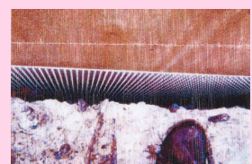
高架道路のエキスパンション
