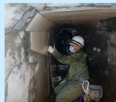
シート差込み状況
