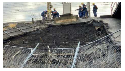
のり面下から
