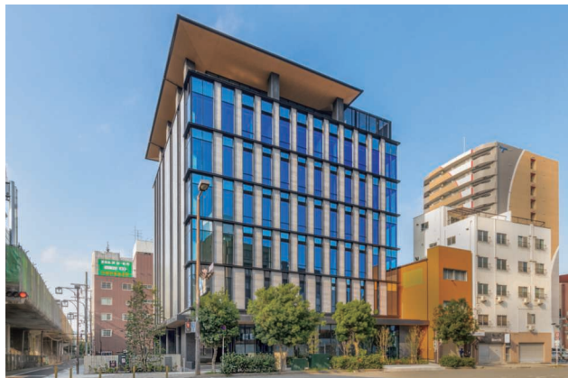
工事名：(仮称) DG日本橋ビル新築工事 発注者：株式会社デンキョーグループホールディングス
