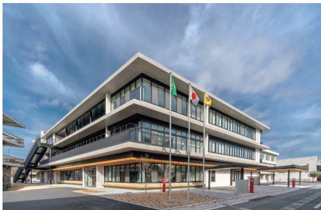
工事名：美祿市新本庁舎建築工事 発注者：美祿市
