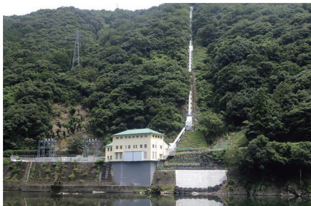
工事名：内谷第一発電所 リニューアル工事 土木工事 内谷第二発電所 リニューアル工事 土木工事 発注者：JNC株式会社
