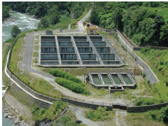
ポカラ上水道改善計画 発注者：ネパール連邦民主共和国水道公社
