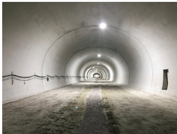
県道高松坂出線（五色台工区） 道路改築工事（五色台トンネル）（坂出側工区） 発注者：香川県
