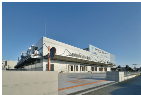
九州新工場計画（建築工事） 発注者：ヤマエ久野株式会社
