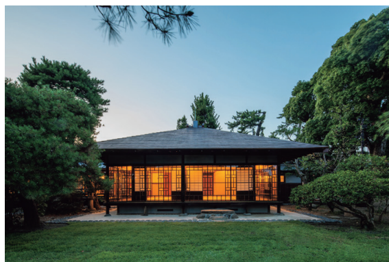
明治記念大磯邸園東地区（21）建築改修その他工事 発注者：国土交通省関東地方整備局
