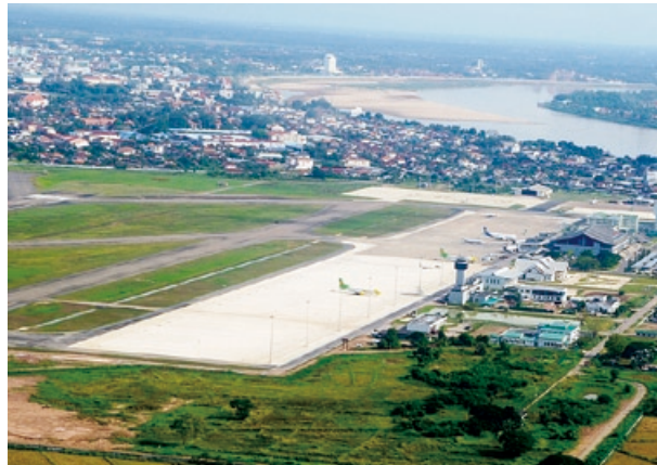
工事名：ピエンチャン国際空港拡張計画（ラオス） 発注者：ラオス人民民主共和国公共事業運輸省航空局
