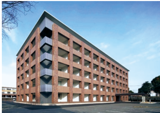
工事名：九州森林管理局庁舎耐震改修工事（熊本県） 発注者：九州森林管理局
