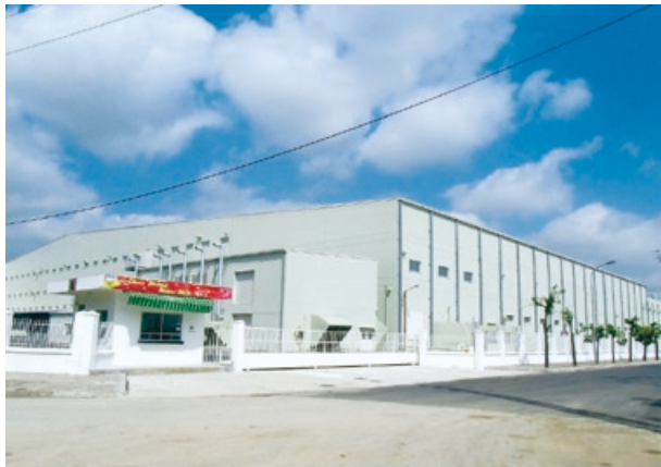
工事名：ブラザーインダストリーズベトナム第4工場建設工事（ベトナム） 発注者：Brother Industries (Vietnam) Ltd.
