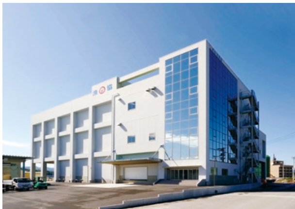
工事名：「平成23年度宮城県水産業共同利用施設復旧支援事業」気仙沼漁業協同組合（復興事業）製氷・貯水施設建設工事（宮城県） 発注者：気仙沼漁業協同組合
