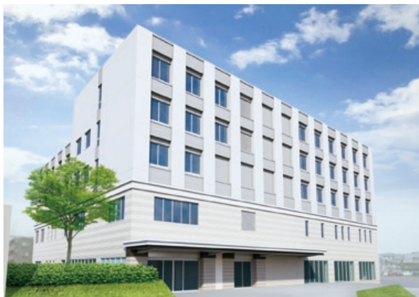
工事名：(仮称) 南東北BNCT研究センター新築工事（福島県） 発注者：一般財団法人 脳神経疾患研究所
