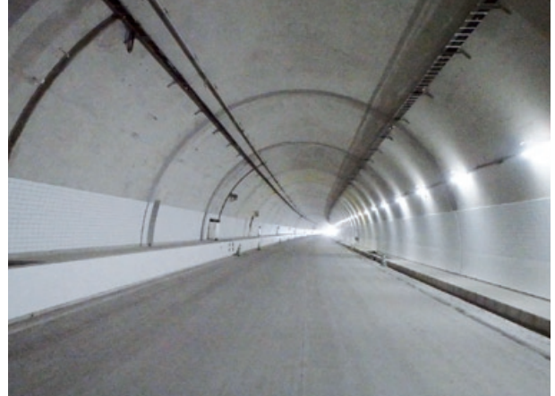
工事名：さがみ縦貫愛川トンネル(その2) 工事（神奈川県） 発注者：国土交通省関東地方整備局
