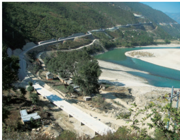
工事名：シンズリ道路建設計画第三工区2/2期後段（ネパール） 発注者：ネパール国公共事業交通省道路局
