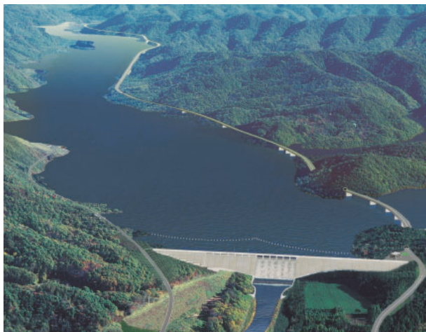
工事名：厚幌ダム建設事業ダム本体工事（北海道） 発注者：胆振総合振興局
