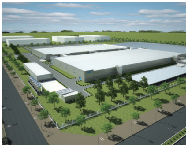
工事名：YKKベトナムニョンチャック工場2期新築工事（ベトナム） 発注者：YKK VIETNAM CO.,LTD
