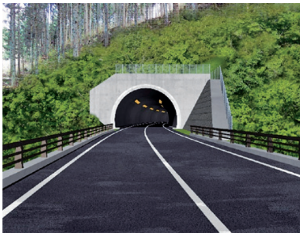
工事名：(仮) うばがふところ 姥ヶ懐トンネル工事（宮城県） 発注者：宮城県
