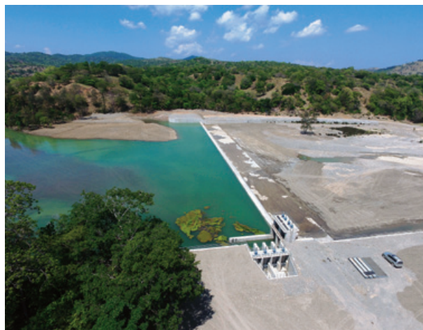
工事名：東ティモール プルト灌漑施設改修計画 発注者：東ティモール民主共和国農業水産省灌漑水管理局
