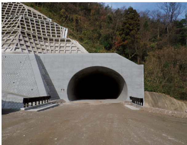
工事名：鳥取自動車道下味野トンネル工事 発注者：国土交通省中国地方整備局
