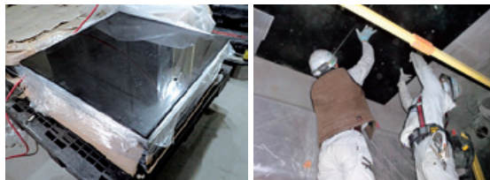
放射化抑制樹脂板と先端医療施設での施工状況
