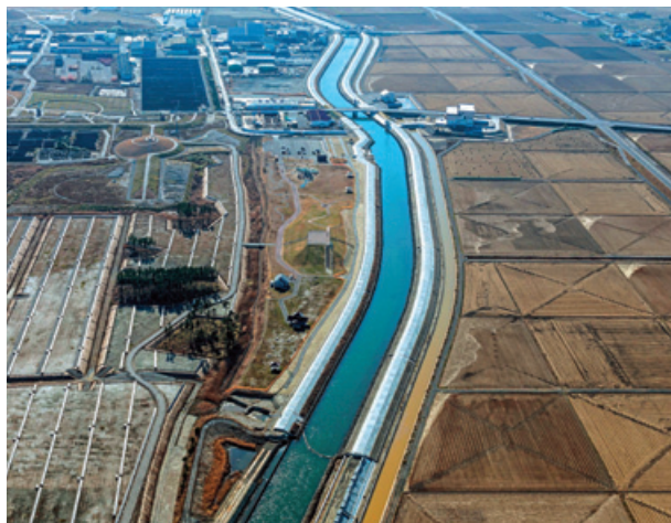
工事名：五間堀川河川災害復旧工事（その10） 発注者：宮城県
