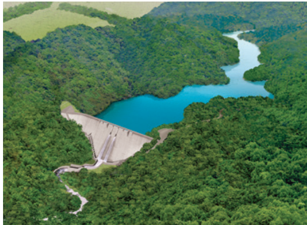
工事名：駒込ダム本体建設工事 発注者：青森県東青地域県民局
