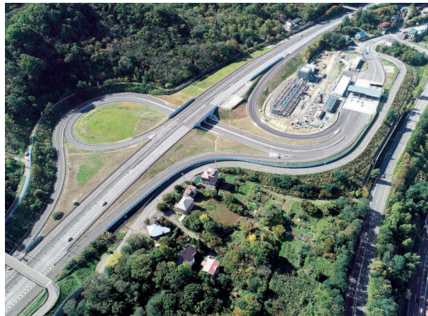
工事名：札幌自動車道 銭函IC改築工事 発注者：東日本高速道路株式会社 北海道支社
