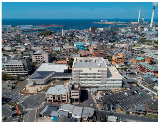
工事名：四国中央市新庁舎建設工事 発注者：四国中央市
