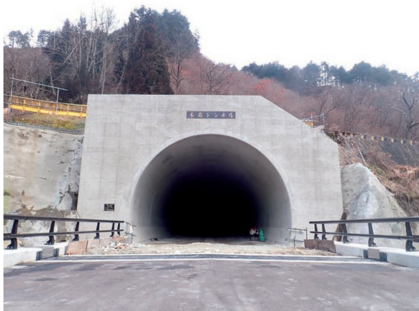
工事名：道路橋りょう整備（再復）工事（トンネル） 発注者：福島県
