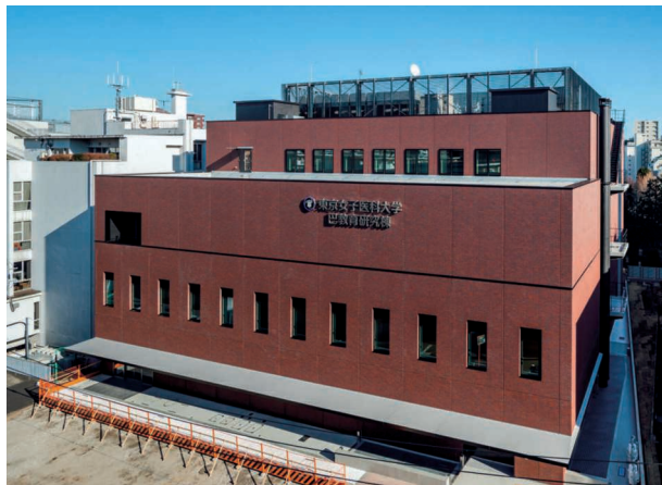
工事名：東京女子医科大学河田町キャンパス（仮称）新校舎棟2新築工事 発注者：学校法人東京女子医科大学
