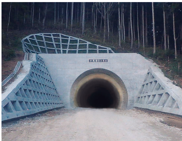
工事名：国道399号 十文字トンネル工事 発注者：国土交通省東北地方整備局
