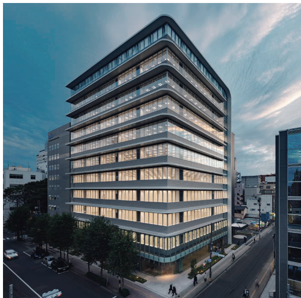
工事名：新仙台ビルディング新築工事 発注者：株式会社七十七銀行・株式会社仙台ビルディング
