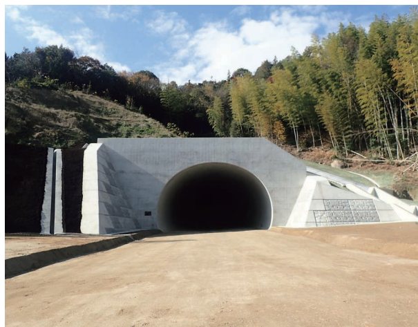
工事名：玉島笠岡道路六条院トンネル工事 発注者：国土交通省中国地方整備局
