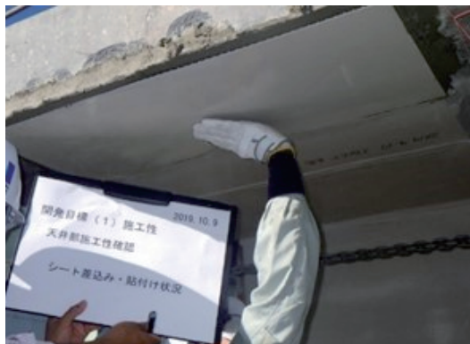
写真-3 シート差込み状況 (天井部)
