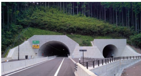
二重峠トンネル(阿蘇工区) (熊本県)
