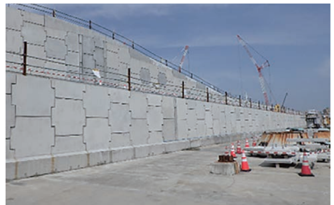
完成した防潮堤の一部
