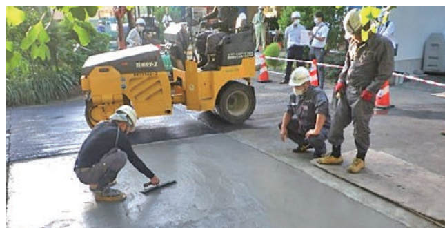
試験施工状況
