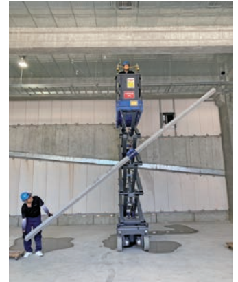
角パイプの建て起こし状況
