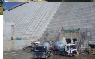
LHC®打設状況(厚幌ダム下流面)
