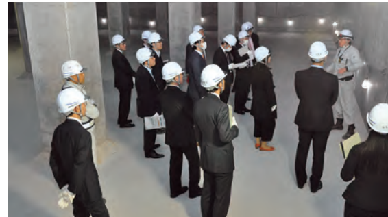
配水池内で説明を行った現場見学会
