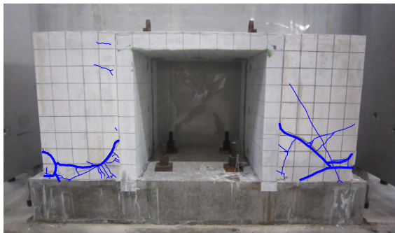
写真-2 試験体および改良体の損傷状況
