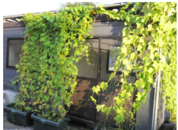
写真-5 グリーンカーテン設置状況 (試験B-北側)
