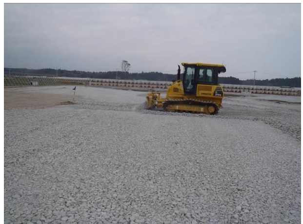
写真-9 AC-Sを使用した施工状況
