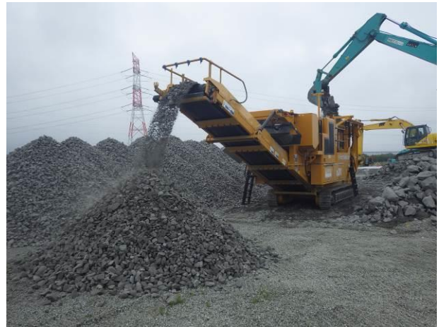
写真-7 自走式破碎機による破碎状況
