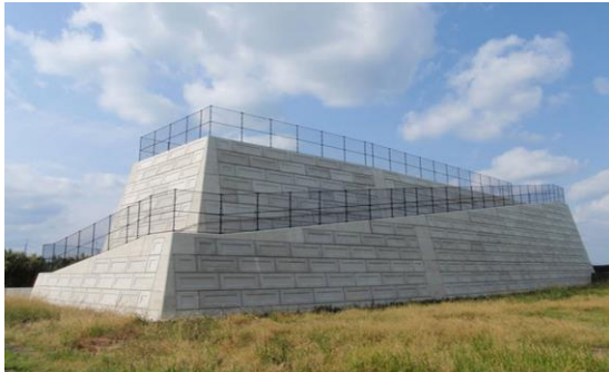
写真－4 津波対策避難所設置工事
