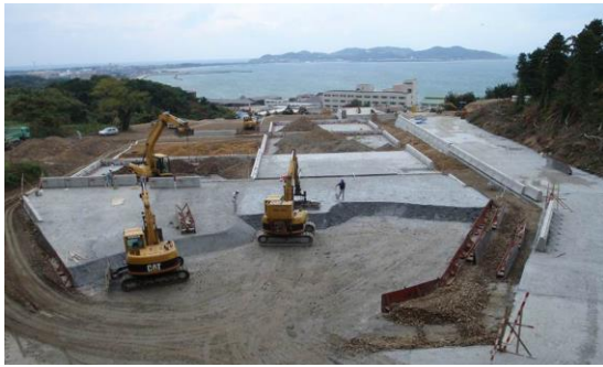
写真－3 宅地造成工事
