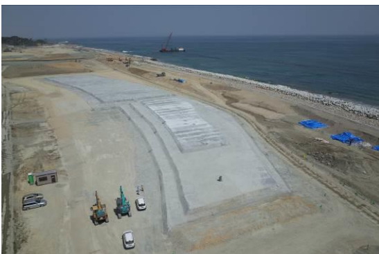
写真－5 防災緑地盛土工事
