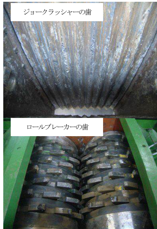
写真-6 破碎機の歯の外観
