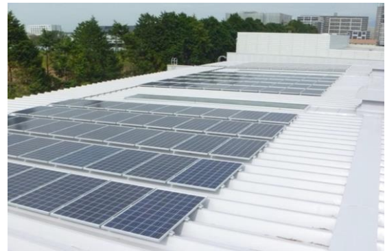
写真-2 太陽光発電設備設置状況
