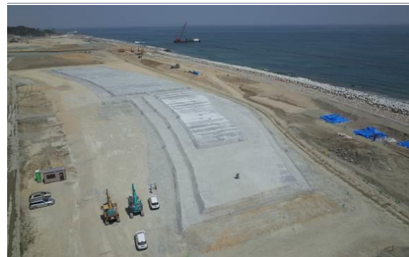
写真-1 Type II適用盛土工事
