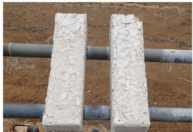
d) ケースA-2 拡大写真 (屋外曝露776日)
