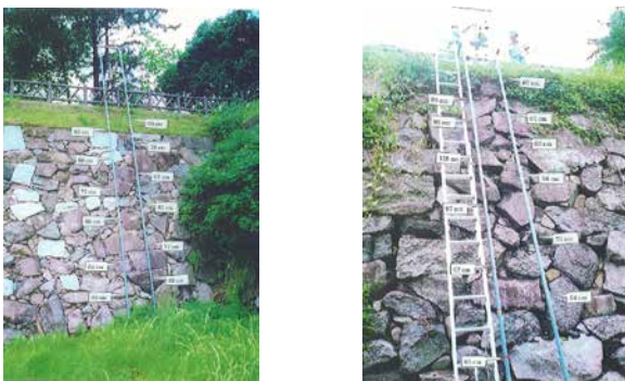
写真-8 石垣背面探査実施地点 左：健全部，右：劣化部
