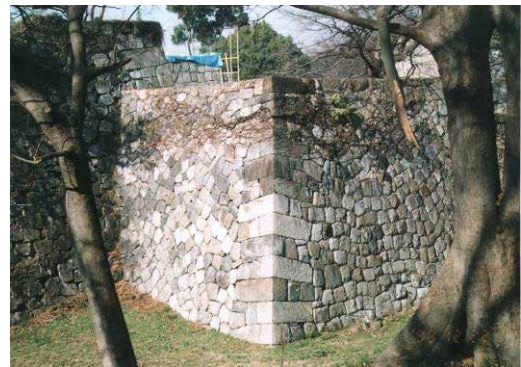
写真-7 レーダー探査箇所（地点②）
