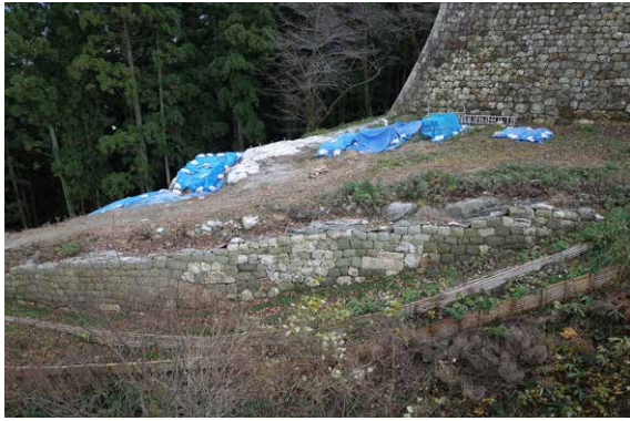
写真-4 UAVによる山城石垣の写真 2)
