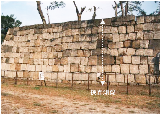
写真-5 レーダー探査実施箇所（地点①）
