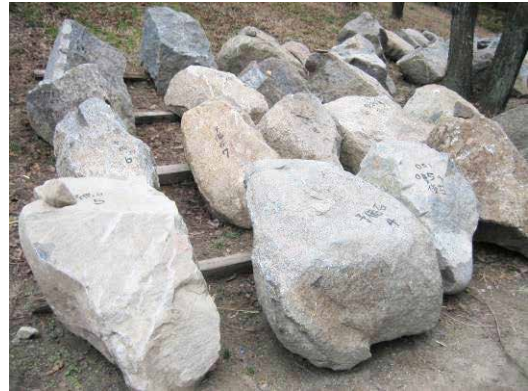
写真-6 築石（野面石および打ち込み接ぎ）
