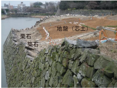
写真-2 石垣の三層構造
