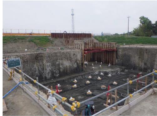
図-4 掘削完了後の地盤改良土留め
