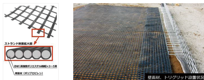
図-3 検討に用いたジオテキスタイルの概要
