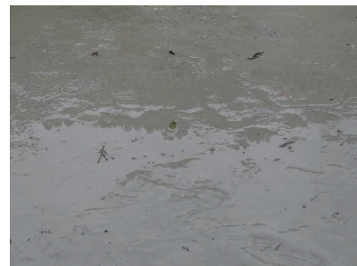
(a) 処理前の打設面
