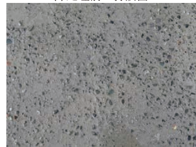
(b) 適切に処理された打継面
