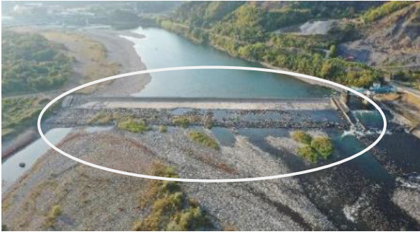
図－21 水域・陸域が混在した現場状況
