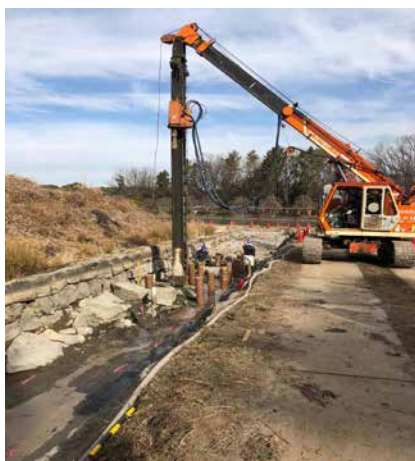
写真-11 杵工の施工状況
