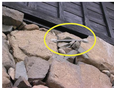
写真-5 ガラス板による目地変位の観測
