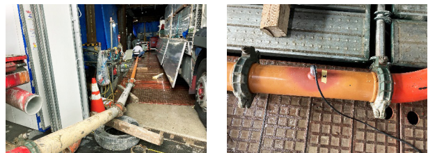
写真-1 圧送状況と計測状況
