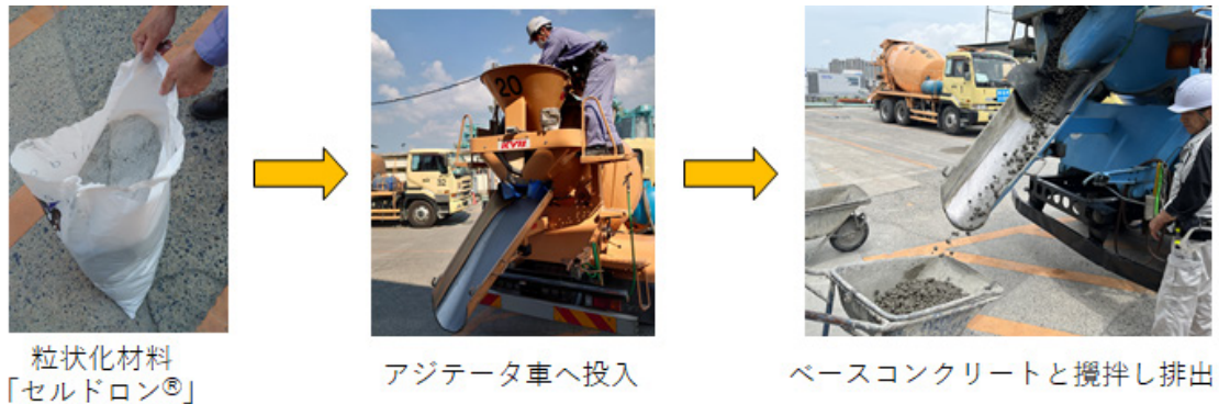
写真－1 「セルドロン®」配合緑化コンクリートの製造方法
