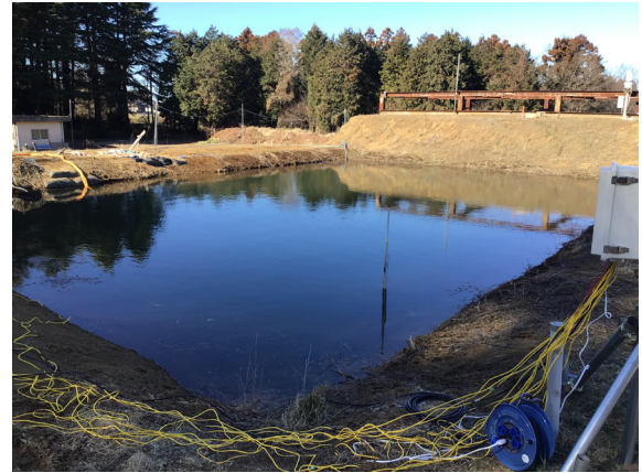
写真 5.1 湛水試験状況 (無対策)
