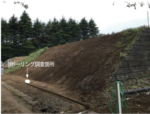
写真 3.2 試験施工対象法面
