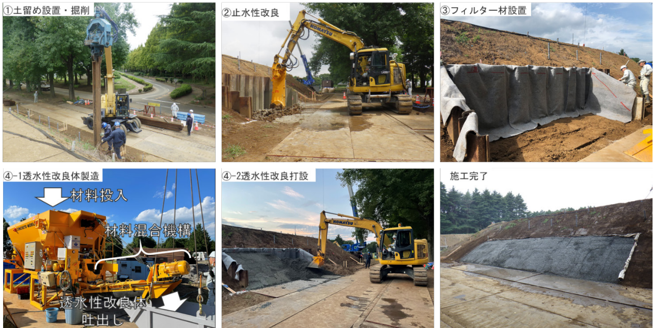
写真 4.1 試験施工の状況写真
