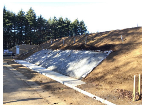
図 5.3 湛水試験時の法面の状況 (対策有)
