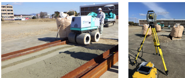
写真-2 施工試験の状況
