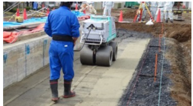
写真-1 既往検討 7) における転圧状況
