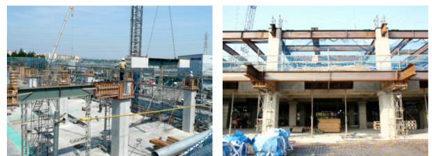
写真-3 AHBS構法の実施例
