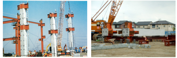
写真-1 建て逃げ可能なプレキャスト工法 (ACSS 工法)
