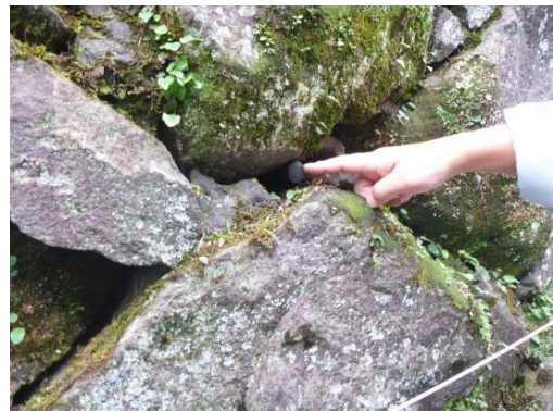
写真-10 鉄筋挿入工法施工後の状況
