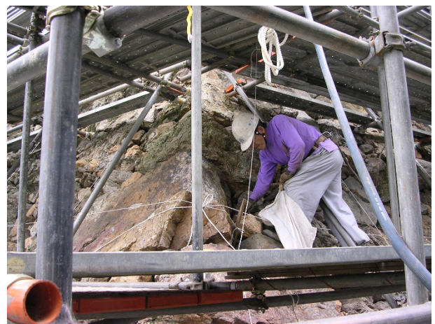
写真-6 間詰石工の作業状況
