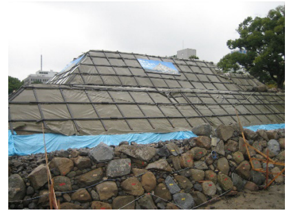
写真-4 石垣背面の保護工の例
