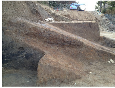
写真-3 背面地盤内の遺構（施工面）
