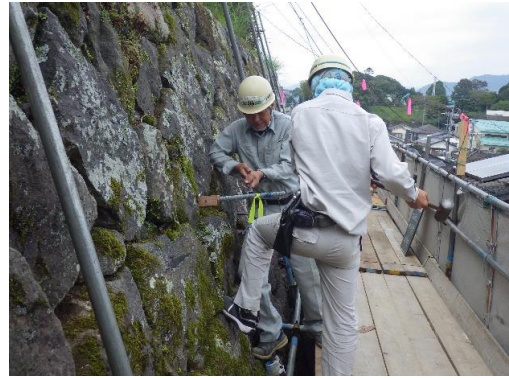
写真-8 人力による鉄筋打ち込み状況
