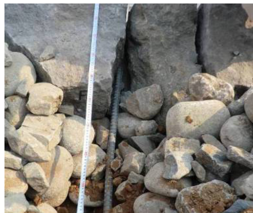
写真-11 鉄筋の打設状況
