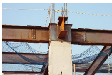
写真-1 RCS造 (APRSS 構法)
