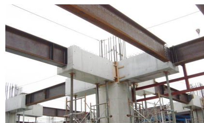
写真-2 端部RC造中央S造梁 (AHBS 構法)
