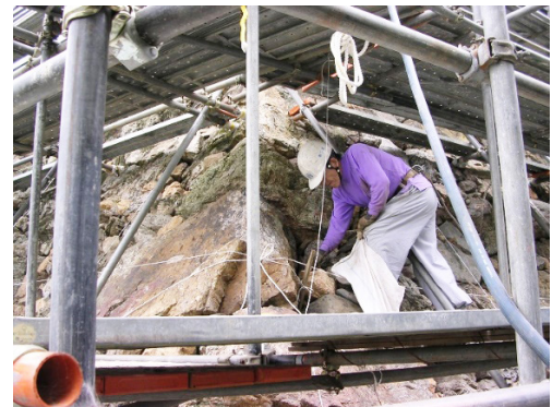
写真-1 間詰石工の施工状況
