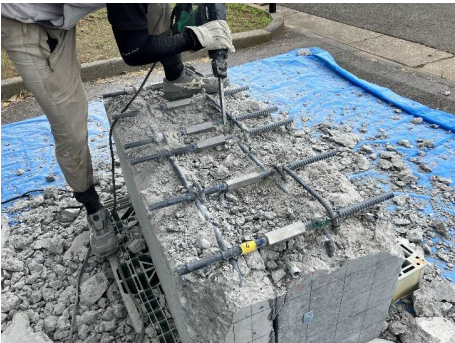
写真－7 継手の研り出し状況
