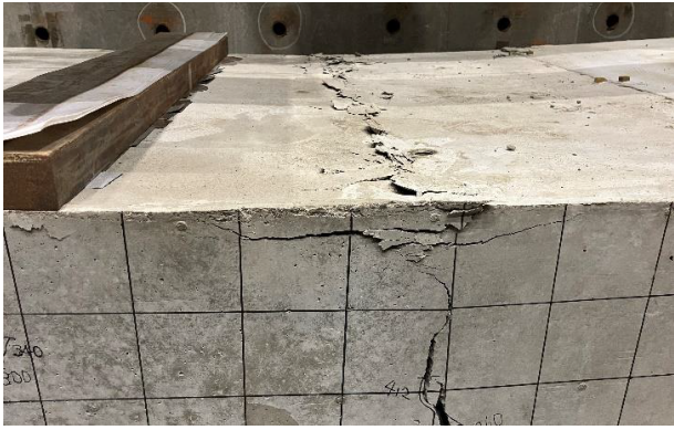
写真-6 実験後のコンクリート圧壊状況 No. 2
