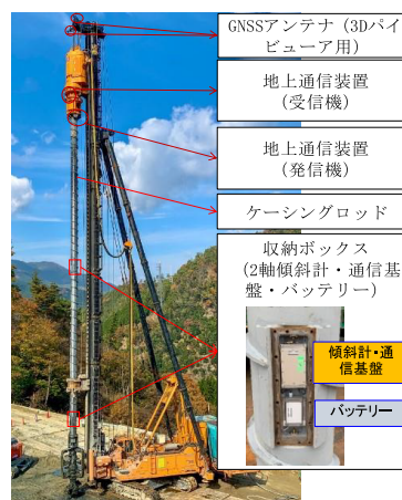
図－2 施工機全景
