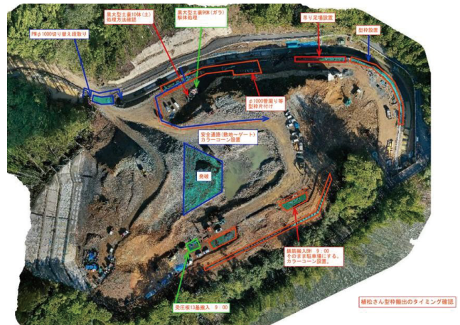
図-12 オルソ画像を用いた作業指示書の例
