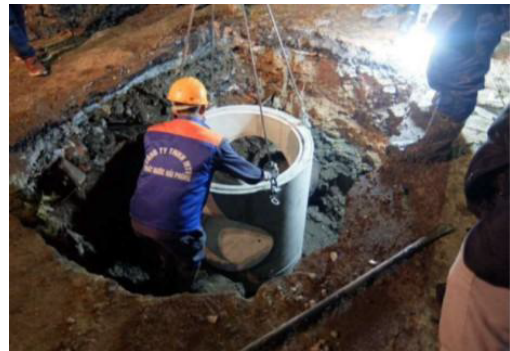
写真－9 組立マンホール設置状況（G3：腐食抑制剤 C）
