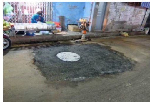
写真－10 マンホール布設替え状況（G3：腐食抑制剤 C）
